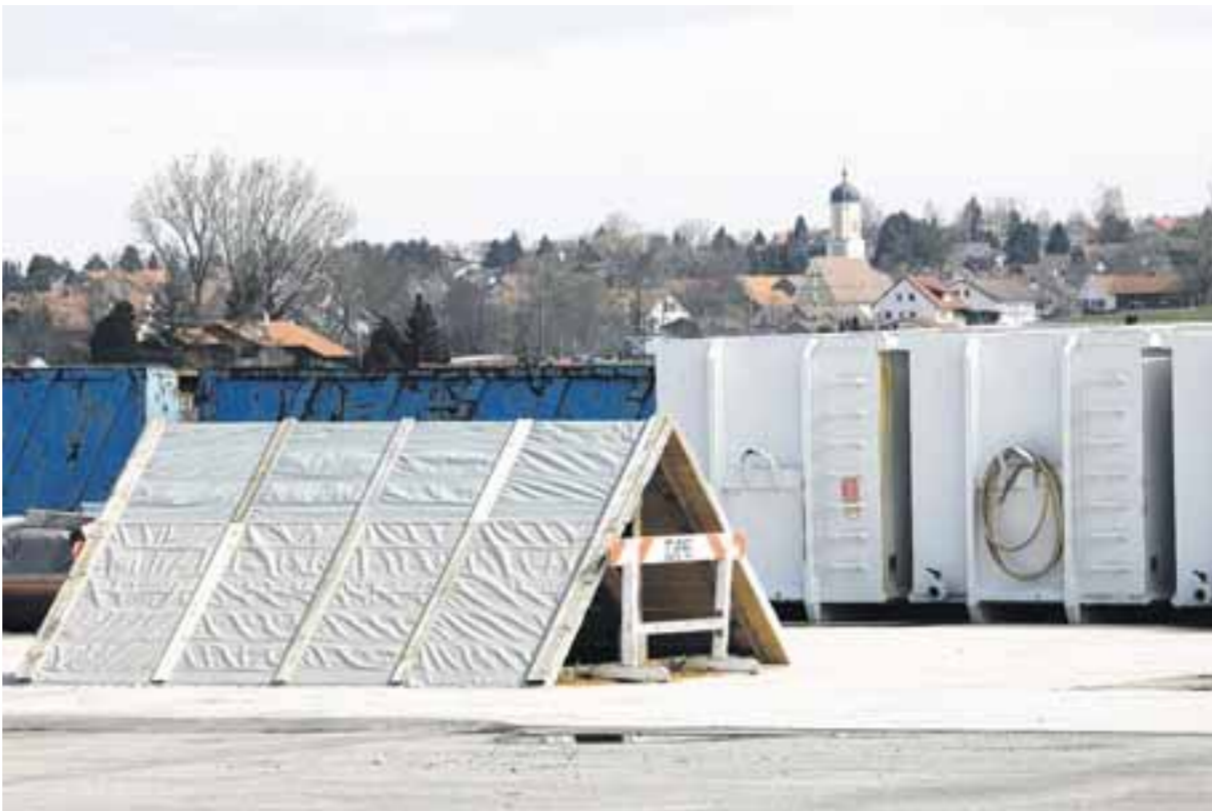
Weiterhin herrscht vordergründig Stillstand auf dem Geothermie-Bohrfeld zwischen Mauerstetten und Kaufbeuren. Das Bohrloch (mit Dach) ist verschlossen und gesichert. Derzeit werden die Möglichkeiten des weiteren Vorgehens analysiert. Foto: Mathias Wild
