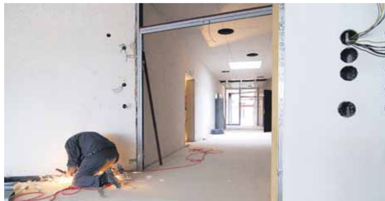
Die letzten Installationsarbeiten laufen. Im September öffnet der Jugendtreff in der Neugablonzer Turnerstraße und bietet neben Gruppenräumen auch einen Sportbereich. Foto: Mathias Wild
